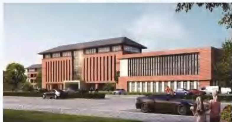
▲ 临泉县兴业路九年一贯制学校 (和顺小学)
