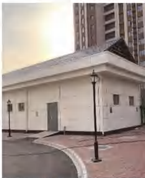
▲ 雄安新区朱河变电站
