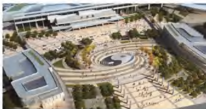
▲ 成蒲铁路站房及生产生活房屋工程-成都西站
